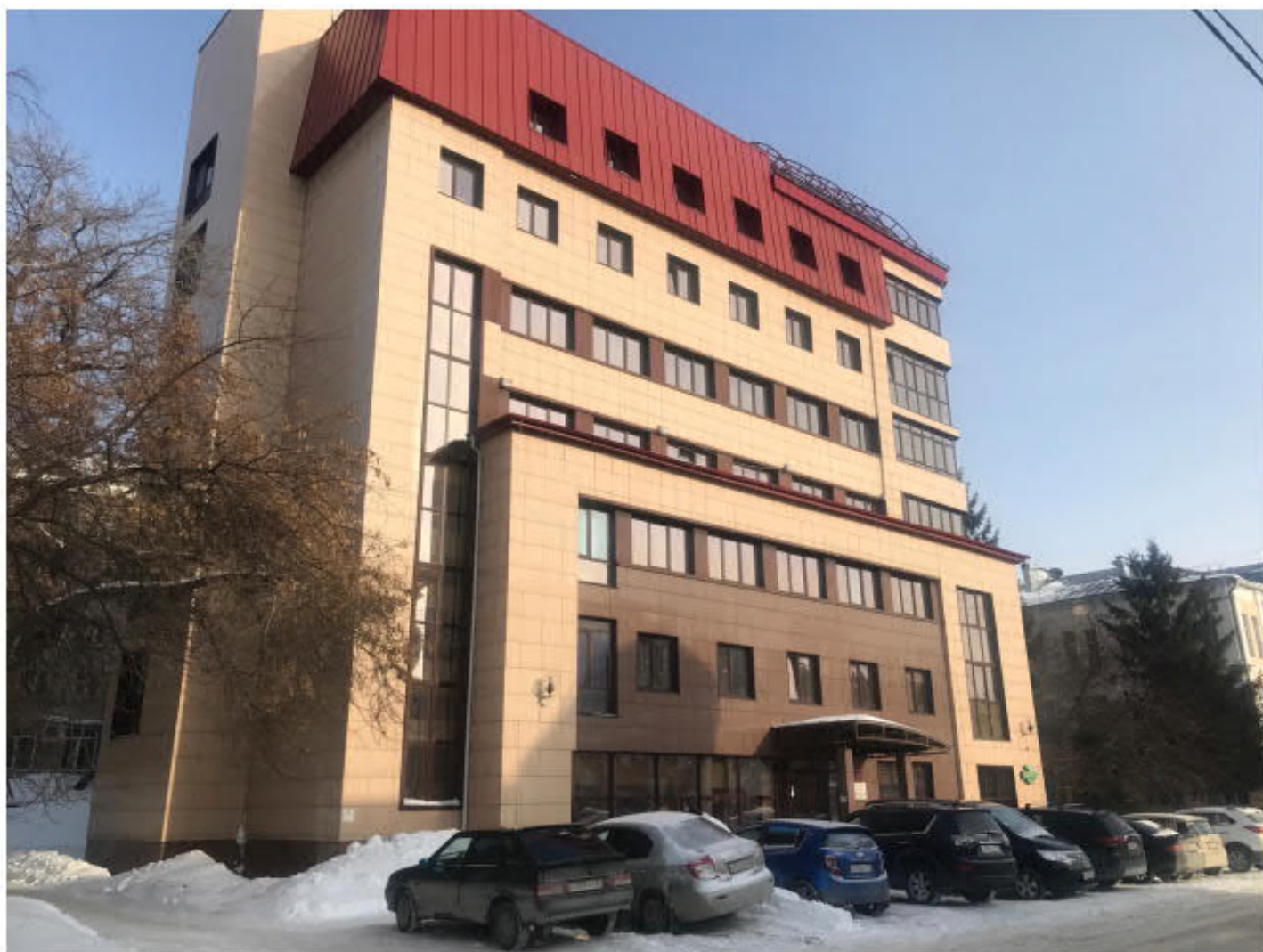
Фото 1 – Гостиница, по адресу: г. Барнаул, ул. Короленко 60
